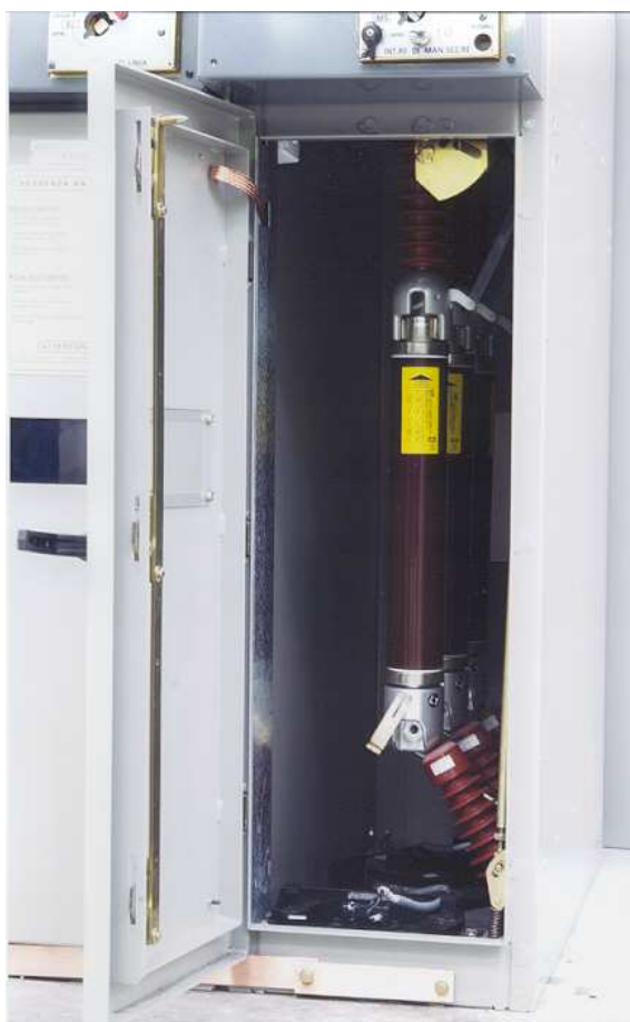
Fot. 1 i 2 – widok pola z bezpiecznikami SN oraz sposób ich montażu
