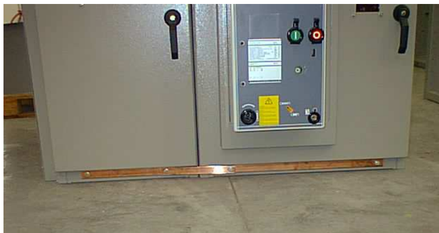
Fot. 7 – widok połączenia szyny uziemiającej
