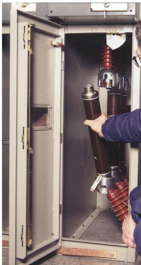
Fot. 1 i 2 – widok pola z bezpiecznikami SN oraz sposób ich montażu
